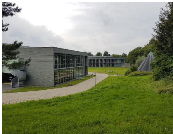
Abbildung 10: Neuere Gebäude der Berufsschule
