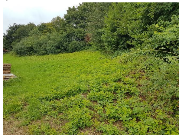
Abbildung 13: Lückig bewachsene südexponierte Böschung
