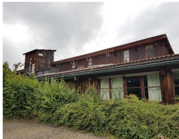
Abbildung 11: Ältere Gebäude mit Holzverkleidung, die durch Neubauten ersetzt werden sollen
