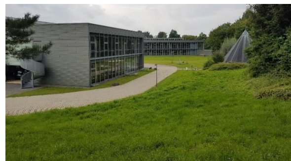
Abbildung 16: Blick aus Nordosten auf das Plangebiet
