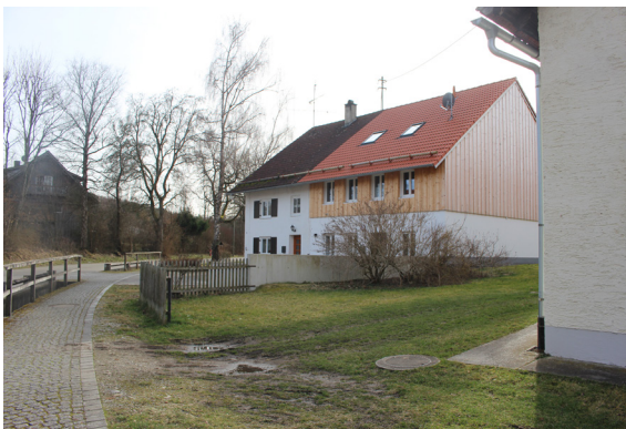
Umbau Tenne zu Wohnhaus
