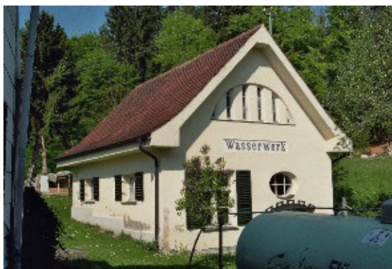
Wasserwerk (südlicher Ortseingang)
